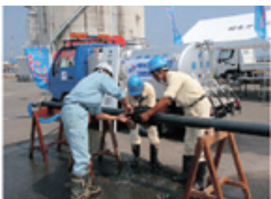
復旧作業状況
