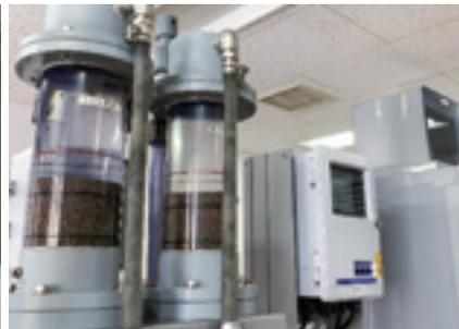
24時間連続して浄水処理の段階ごとに水質異常がないか自動で水質測定、監視を行います。
